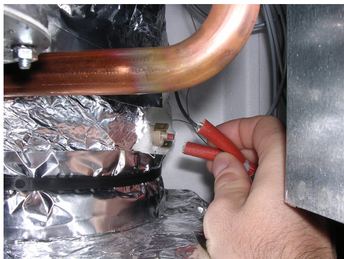
Ábra 2 – Generátor határoló termosztát ellenőrzés
